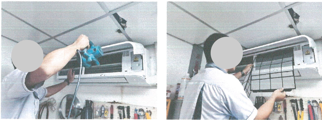
รูปภาพที่ 2.28 การล้างทำความสะอาดแอร์
