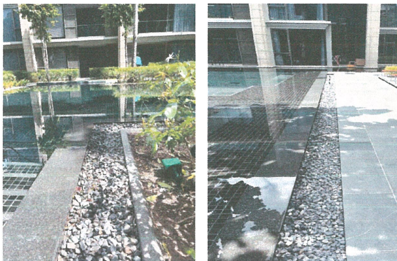
รูปภาพที่ 2.39 รางระบายน้ำด้านของสระว่ายน้ำ
