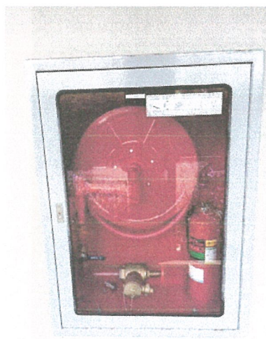
รูปภาพที่ 2.45 ตู้เก็บสายฉีดน้ำดับเพลิงพร้อมอุปกรณ์
